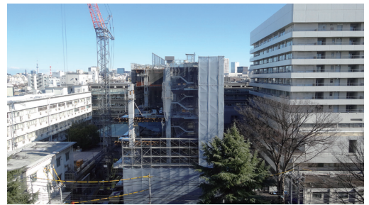
紅梅寮屋上より見た I 期棟建設状況 (2015年1月23日撮影)
