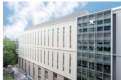
1号館（新病院棟）Ⅰ期棟南面
