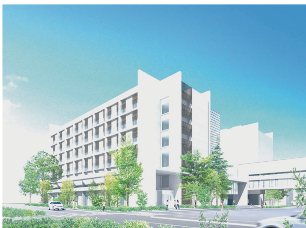
▲ 3号館（南棟）1～6階 2012年4月竣工予定
